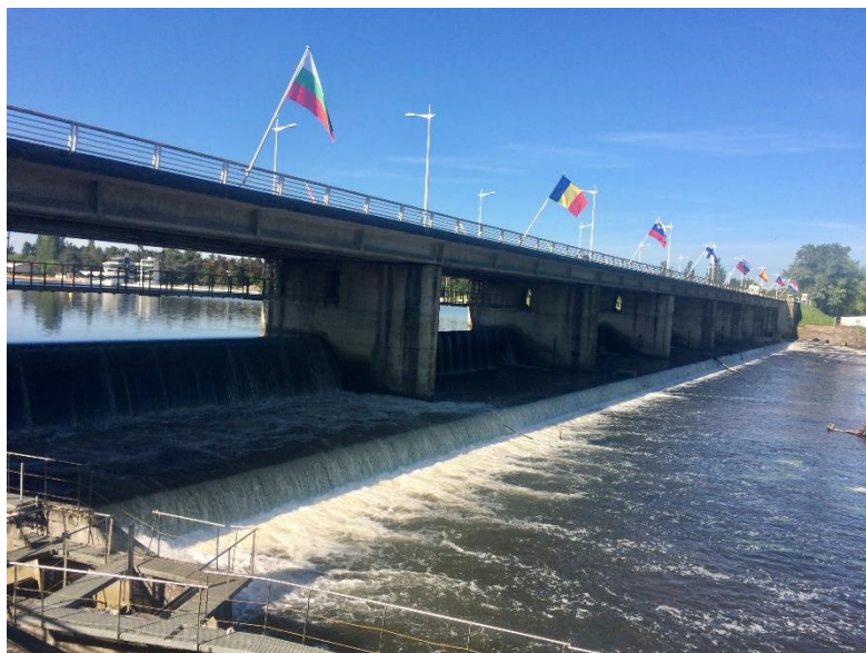
Le pont barrage sur l'Allier et l'observatoire des poissons migrateurs dans la passe à poissons
