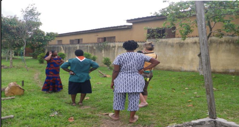
Vue de derrière View from behind le mur the wall
